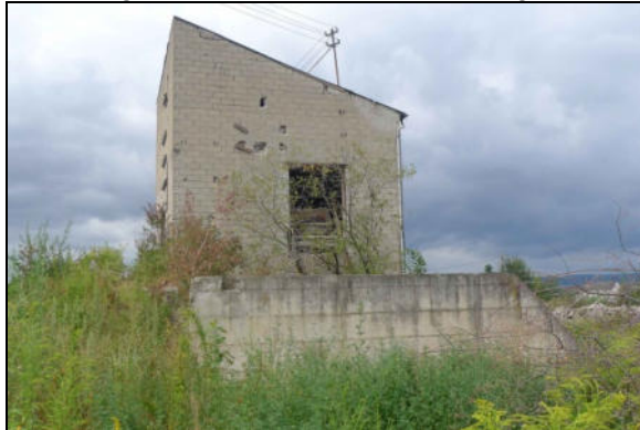
Abbildung 7: leerstehendes Betriebsgebäude im zentralen Bereich des Plangebiets
