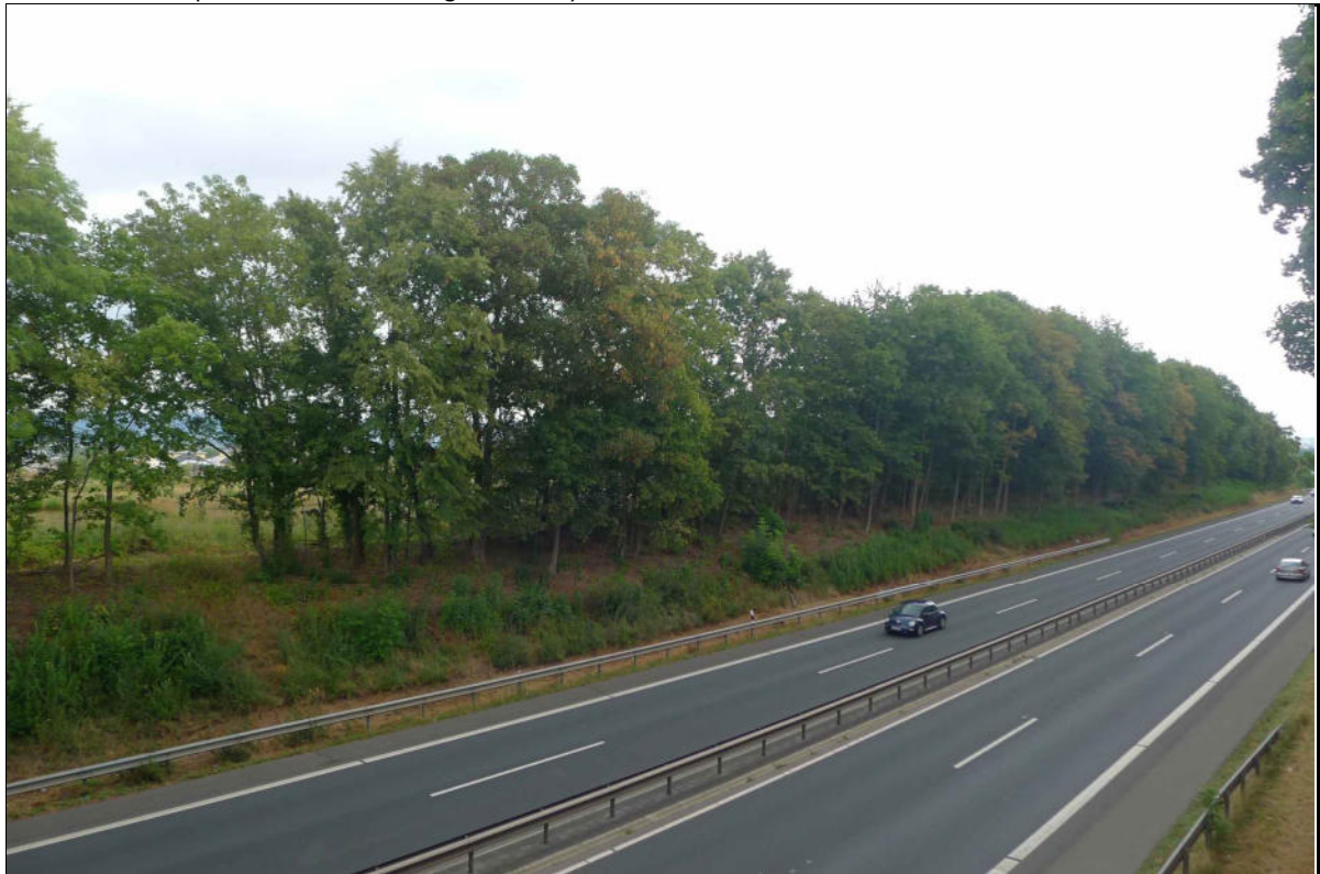
Abbildung 16: Blick in Richtung des Plangebiets von der Brücke über die B 9 (Blickrichtung Südwesten → Nordosten); der Baumbestand wurde zwischenzeitlich ausgelichtet (Aufnahme vom August 2018)
