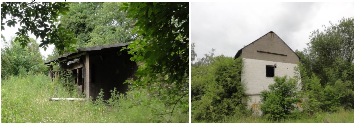
Abbildung 2: Beispiele für leerstehende Gebäude
