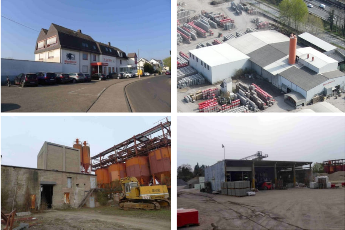
Abbildung 4: Beispiele für Gebäude innerhalb des Betriebsgeländes
