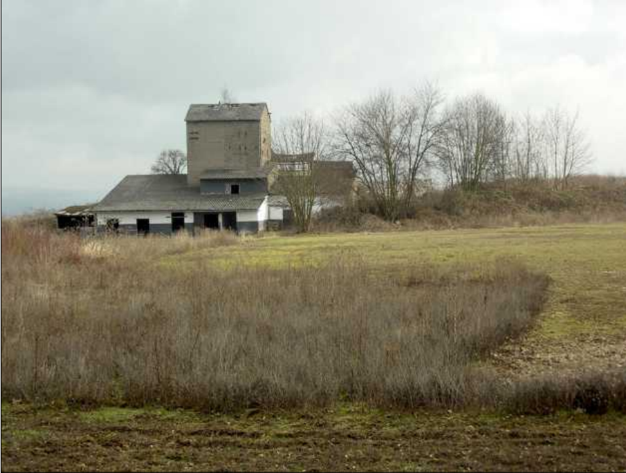
Foto 2: Das frühere Reitstallgebäude am Wall mit 2018er Rauchschnalbenkolonie zum Abbruch. Blick aus West nach Ost. 22.02.19-HGF
