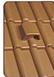
Abb. 10: Empfohlene Dacheinschlupfe mit Fledermausstein Fa. Braas.
