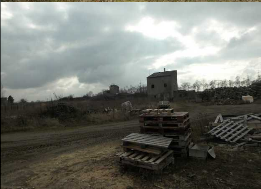
Foto 7: Gewerbliche Nutzung findet dazu in großen Teilen im Nordwesten statt. Blick aus Nord nach Süd zu den beiden Gebäuden. 22.02.19-HGF
