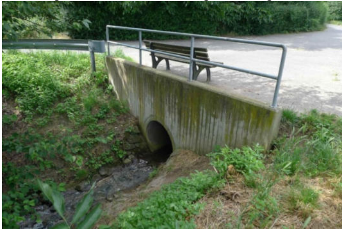
Abbildung 31: Ende der Verrohrung des Kettiger Bachs am nördlichen Rand des Plangebiets
