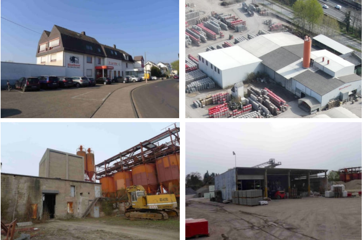
Abbildung 21: Beispiele für Gebäude innerhalb des Betriebsgeländes
